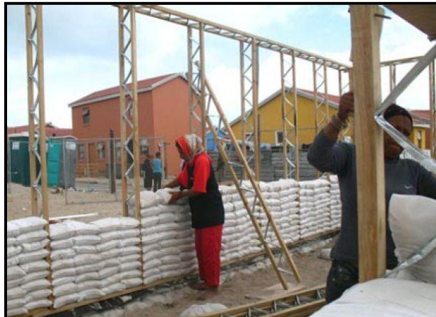
FIGUUR 8c: Konstruksie van 'n muur met houtbalke en sandsakke, Sandsakhuise , Freedom Park, Kaapstad, 2007.
