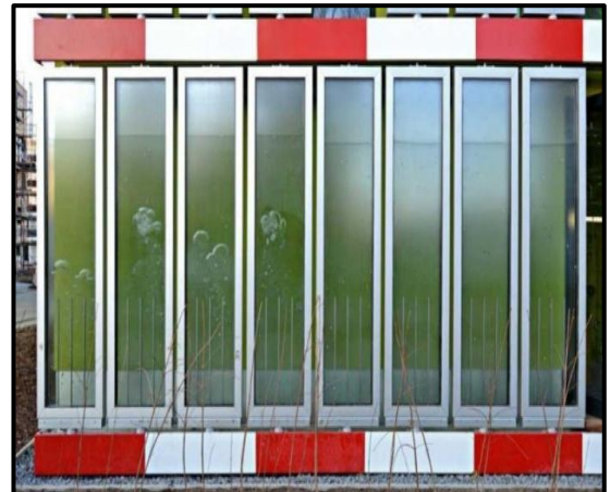
Glaspaneel gevul met vloeibare biomassa-materiaal (alge) wat sy eie elektrisiteit kan voorsien.
