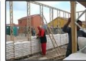
FIGUUR 8c: Bou van 'n muur met behulp van houtbalke en sandsakke, Sandsak Huise , Freedom Park, Kaapstad, 2007.
