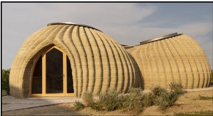
FIGUUR 8c: Mario Cucinella Architects, TECLA 3D gedrukte huis , 2021. Die huis is op die perseel gebou deur 'n mengsel van klei, water, die vesels van rysdoppe en 'n bindmiddel te gebruik. Hierdie herbruikbare, herwinbare, koolstof-neutrale materiaal word in 'n groot 3D-drukker ingevoer wat sirkelvormig beweeg en by enige klimaat kan aanpas.
