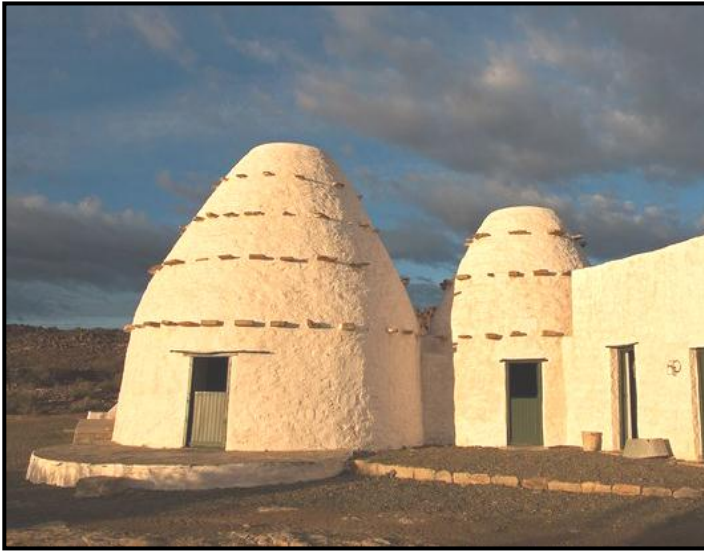
FIGUUR 8a: Witgekalkte korbeelhuse (' corbelled houses '), klip, modder en klei, Stuurmansfonteinplaas, Karoo, 19 de eeu (deur nomadiese boere gebou)
