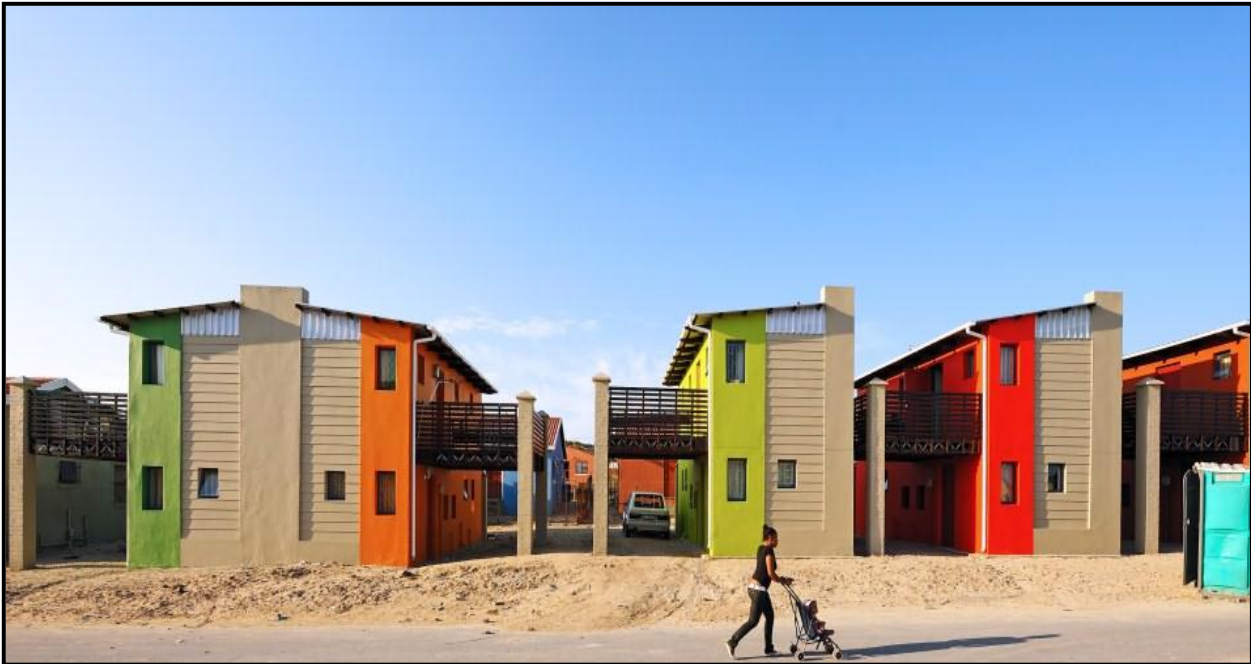
FIGUUR 8a: MMA Architects, Sandbag Houses (Sandsakhuse) , Freedom Park, Kaapstad, Suid-Afrika, houtbalke en sandsakke, 2007.
