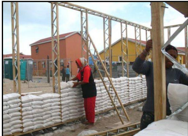
FIGUUR 8c: Konstruksie van 'n muur met houtbalke en sandsakke, Sandsakhuse , Freedom Park, Kaapstad, 2007.
