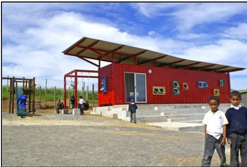
FIGUUR 8b: Tsai Design, oorspronklike idee van die 15-jarige Marshaam Brink, Vissershok Container Classroom project (Vissershok-skeepshouer-klaskamerprojek) , Du Noon township, Suid-Afrika, herwinde skeepshouers, sement, glas en polistireen, 2012.
