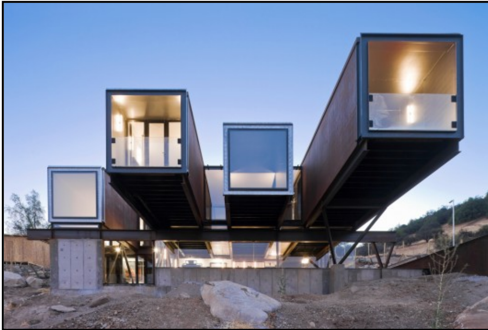
FIGUUR 8a: Sebastián Irarrázaval, Caterpillar House (Ruspewoning) , 'n skeepshouer-gebaseerde gesinswoning wat uitkyk op die Andesgebergte, Chile. Die huis is saamgestel uit 12 skeepshouers wat slaapkamers, leefareas en 'n swembad insluit, 2012.
